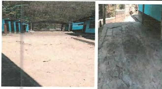
Foto 3: Se realizará losa del patio del centro educativo frente y entrada que esta en estado de tierra y perjudica a los niños y niñas cuando hay lluvia.
